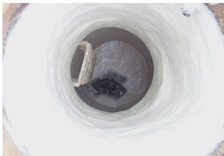
Studnie kanalizacyjne przed i po renowacji z użyciem laminatów żywicznych
