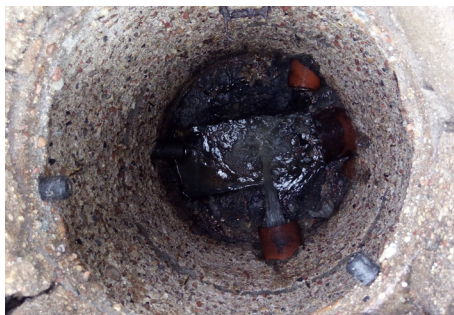
Studnie kanalizacyjne przed i po renowacji z użyciem laminatów żywicznych
