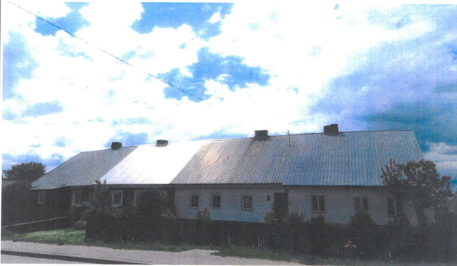
Widok ściany frontowej z NE na SW
