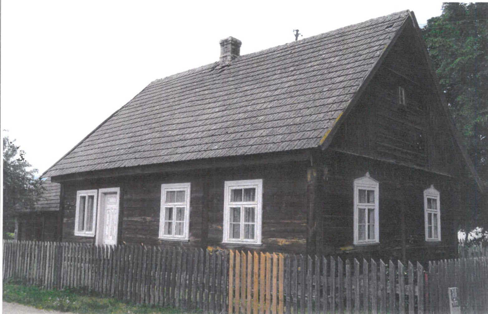
Widok ściany frontowej i szczytowej z SE na NW
