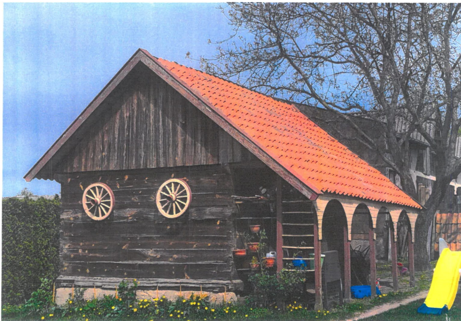
Widok ściany wzdłużnej i szczytowej z NE na SW
